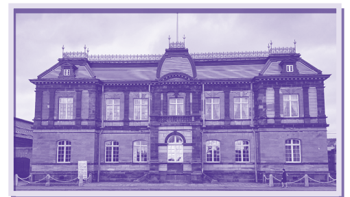
大規模な補修工事を終え公開を再開した 「旧日本郵船株式会社小樽支店」
